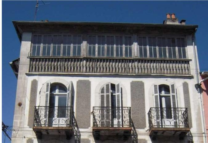
*La trame verticale des vitrages et menuiseries en bois doit être respectée*
