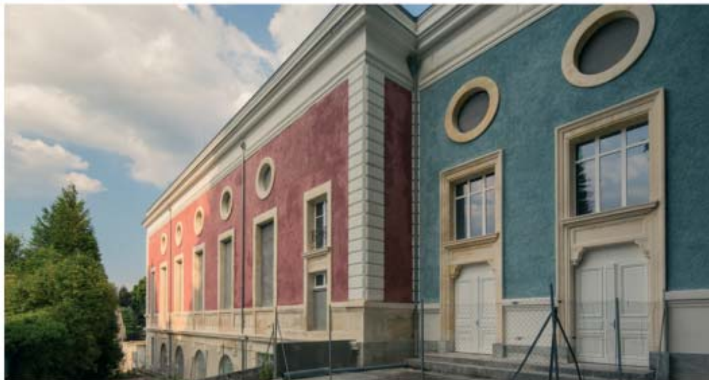
Les menuiseries ont été renouvelées et la pierre naturelle a retrouvé son éclat d'origine.
