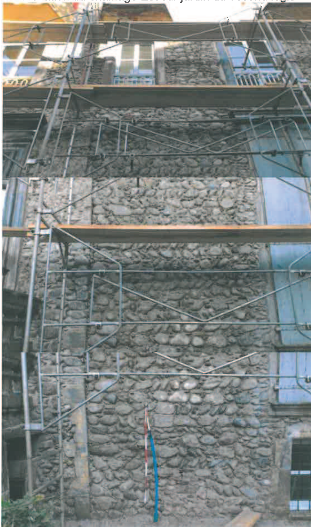
Elévation du chaînage Est sur jardin du second logis
