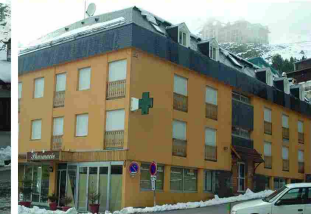
TEINTE D'ENDUIT TROP SOUTENUE
